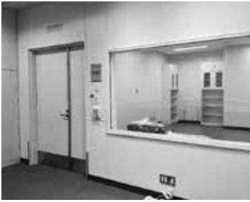
X線透视撮影室です。ここには、多目的の透視撮影装置が入る予定です。
