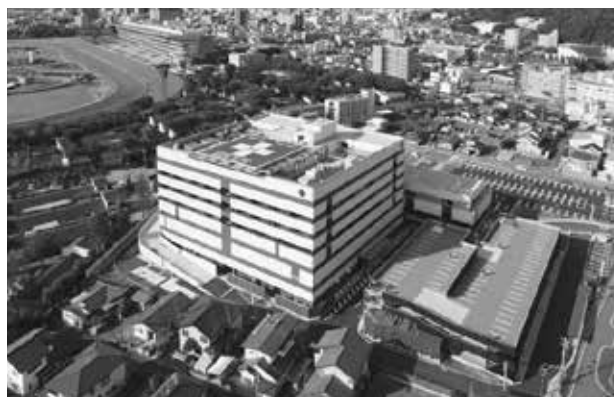
【病院北東側からの外観】
